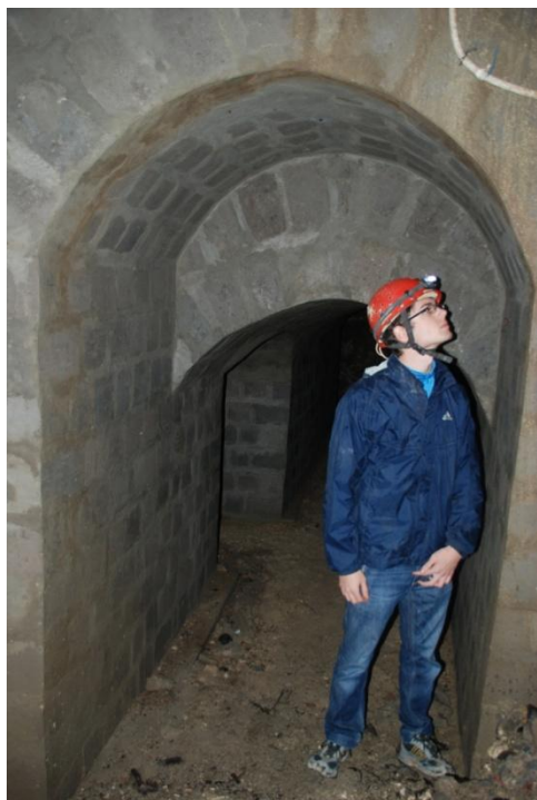
103. fénykép. Véglegesen kibiztosított járat a Bécsi kapu tér alatt.
