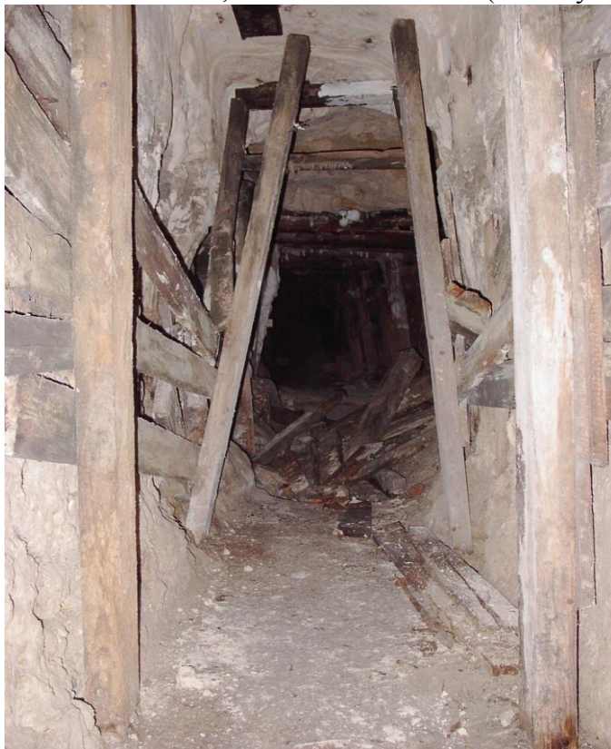
51. fénykép. Tönkrement régi dúccolat a Bécsi kapu tér alatti járatokban 2009-ben.
