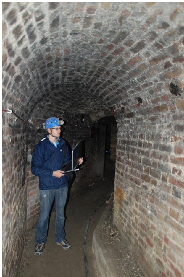
86. fénykép. A 134a folyosó téglaburkolatú járata.
