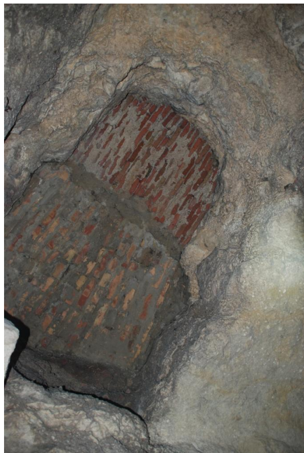
88. fénykép. Nagyméretű elzárt kürtő a 134-es folyosó mennyezetén.
