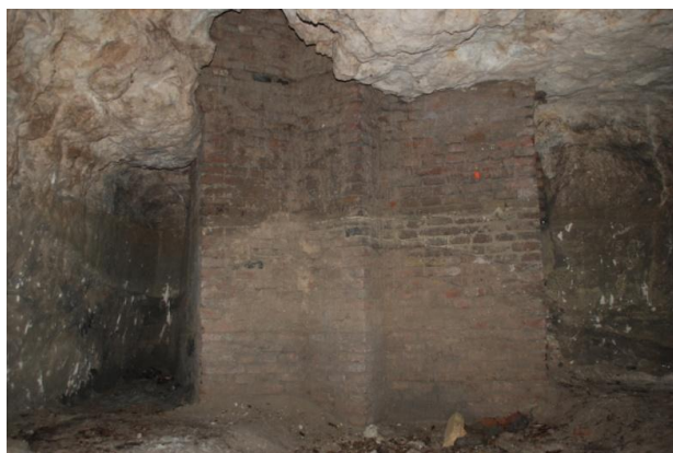
102. fénykép. Az evangélikus templom tartópillére a Bécsi kapu tér alatti barlangteremben.
