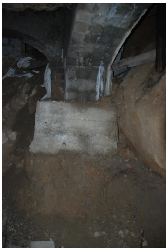
109. fénykép. Omladékra alapozott „kibiztosítás” a Táncsics Mihály utca 21-23. sz. alatti barlangban.
