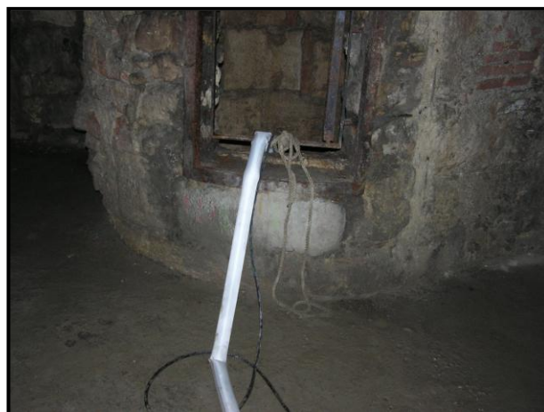
29. fénykép. A Mamutfogas-kút szivattyúzása.
