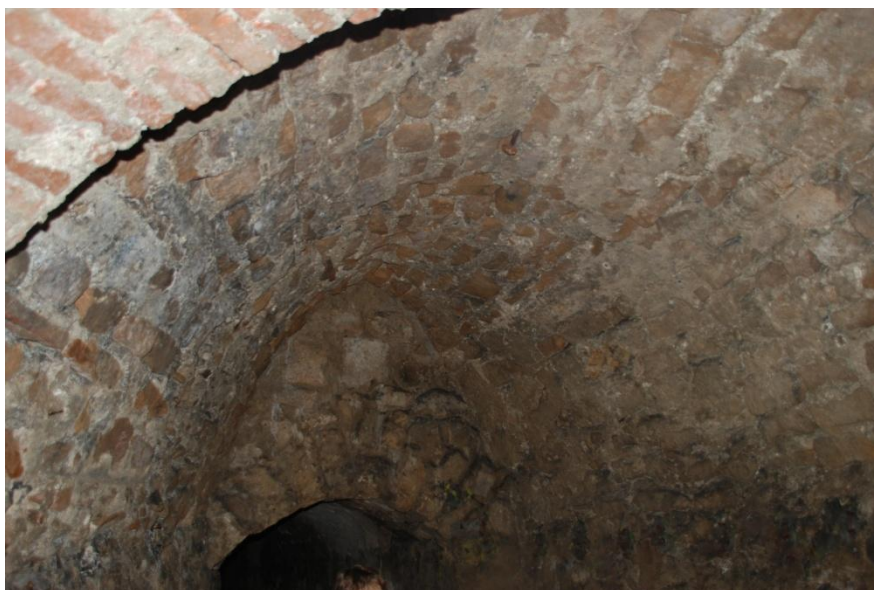
74. fénykép. Süveges boltozat a 10-es sz. folyosóban.
