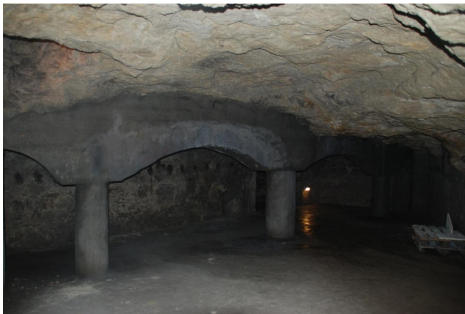
84. fénykép. Vasbeton alátámasztó ívek a 132-es teremben
