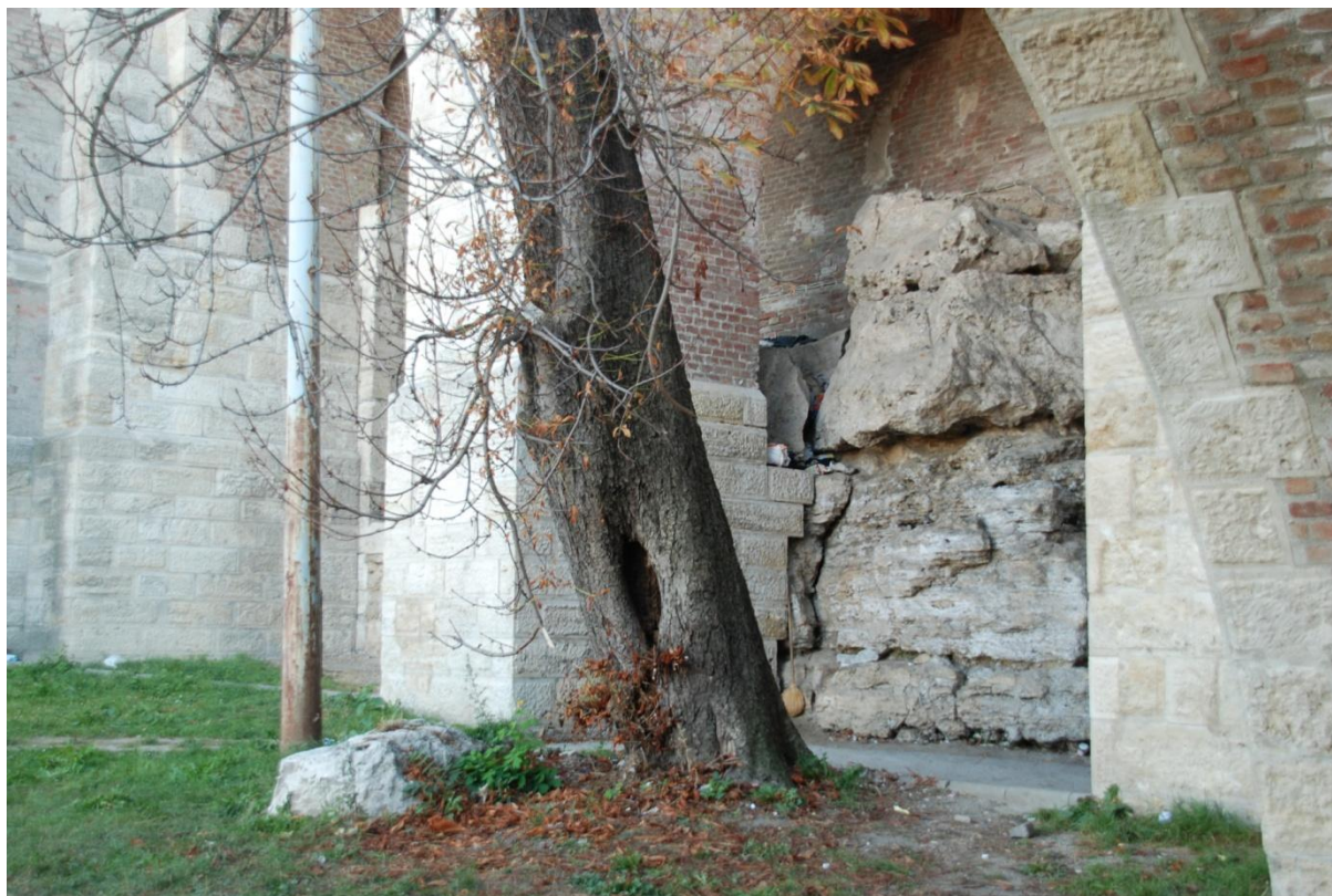
5. fénykép. A várfalat néhol az édesvízi mészkőre alapozták.
