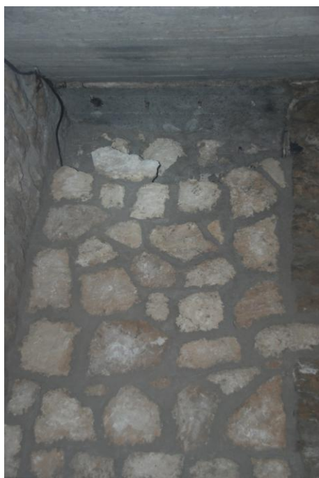
72. fénykép. Terméskő fallal elzárt pincefeljáró a 164-es terem fölött.
