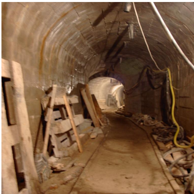
54. fénykép. A volt Állami Nyomda alatti óvóhely vészkijáratí folyosójának átépítése.
