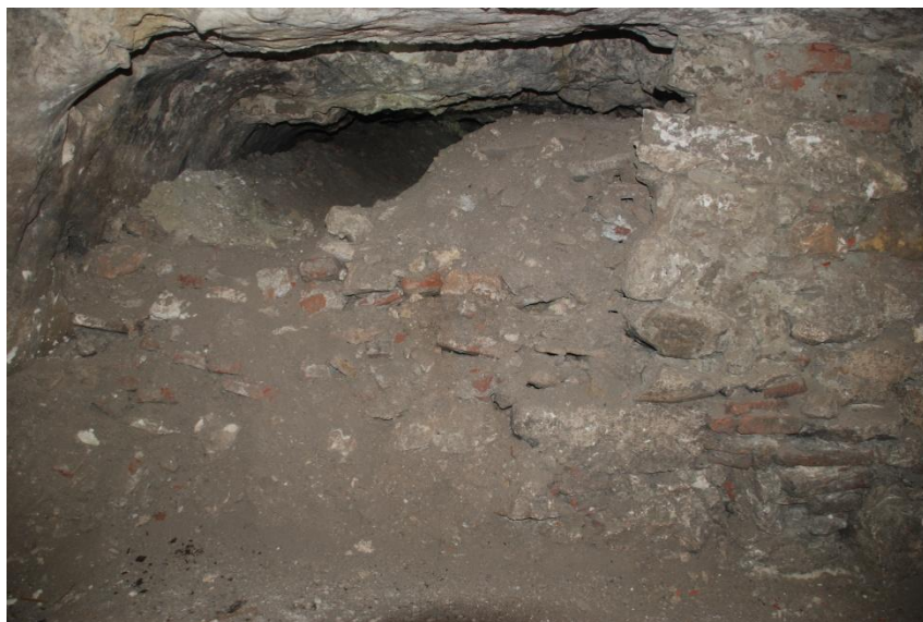
104. fénykép. Rosszul tömedékelt járat a Bécsi kapu tér alatt.
