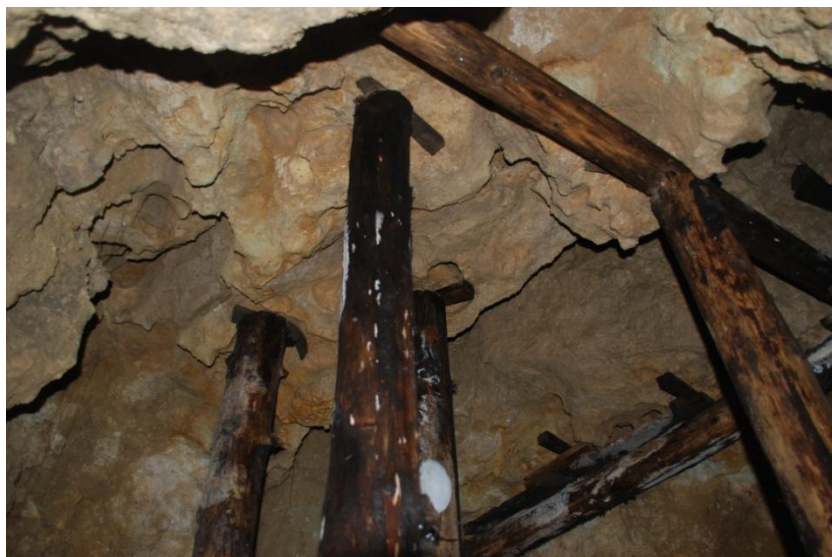
100. fénykép. Aládúcolt barlangi mennyezet a Bécsi kapu tér alatt.
