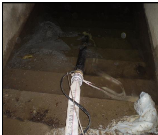
26. fénykép. Az előtört járat szivattyúzása
