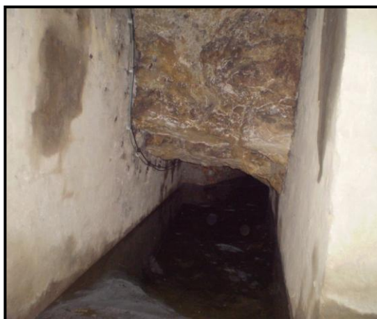
25. fénykép. A Rendőrség-kút által előtört barlangjárat
