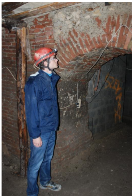
99. fénykép. Régi téglabiztosítás a Bécsi kapu tér alatt.
